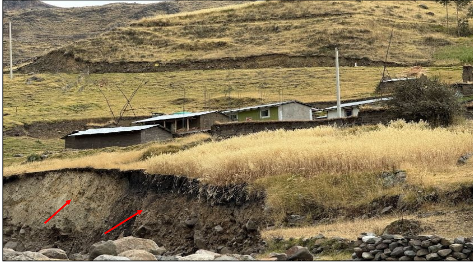
FIGURA N°02: C.P. PUEBLO NUEVO EXPUESTOS ANTE UNA CRECIDA DEL RÍO PIRCAMAYO, EN LA MARGEN IZQUIERDA MUESTRA LA EROSION FLUVIAL AMENAZANDO A LAS VIVIENDAS.
